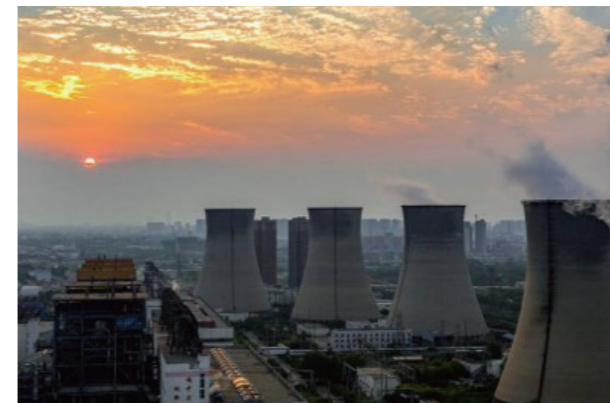
电力电网 | 徐州原坝山热电厂配电工程
