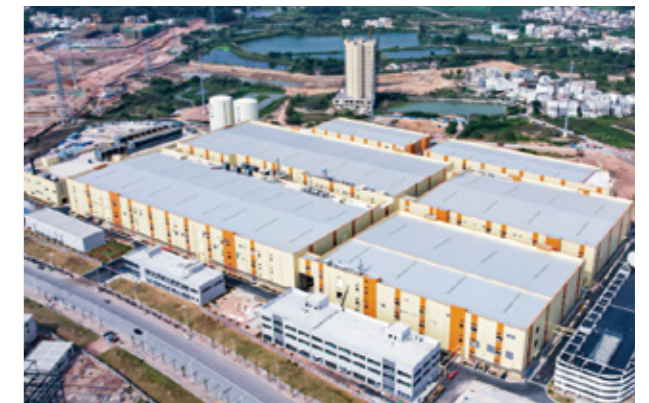
工矿企业 | 惠州亿纬锂能工厂配电工程
