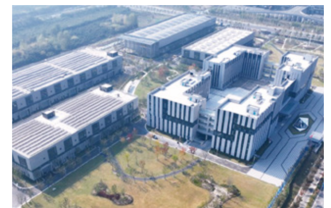
风光储充 | 盐城零碳园区配电工程
