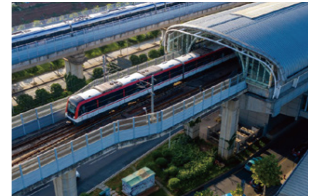
轨道交通 | 长沙市轨道交通6号线配电工程
